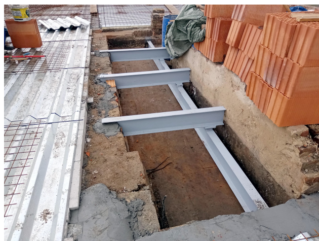
Obr. 6: Nový strop nad 2. NP, doplnění stropnic u schodiště (foto Stavika [3])
