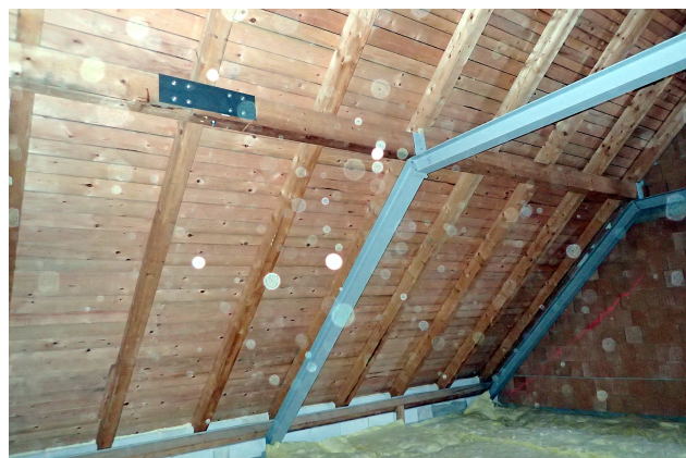
Obr. 8: Konstrukce střechy: kloubový spoj vaznice uprostřed rozpětí.
