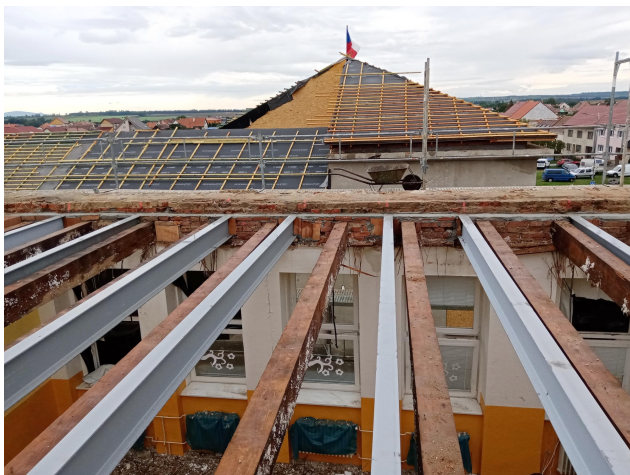
Obr. 4: Nové ocelové nosníky mezi původními dřevěnými ve stropě nad 2. NP (foto Stavika [3])
