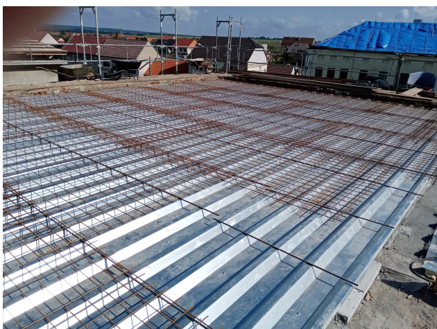
Obr. 5: Nový strop nad 2. NP, uložení a kotvení trapézových plechů (foto Stavika [3])
