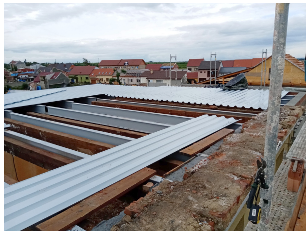
Obr. 5: Nový strop nad 2. NP, přesah nad nadezděnou přístavbu (foto Stavika [3])
