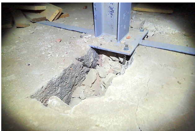
Obr. 10: Sloupek nové konstrukce střechy osazený na otvor ve stropě (komínový průduch?)
