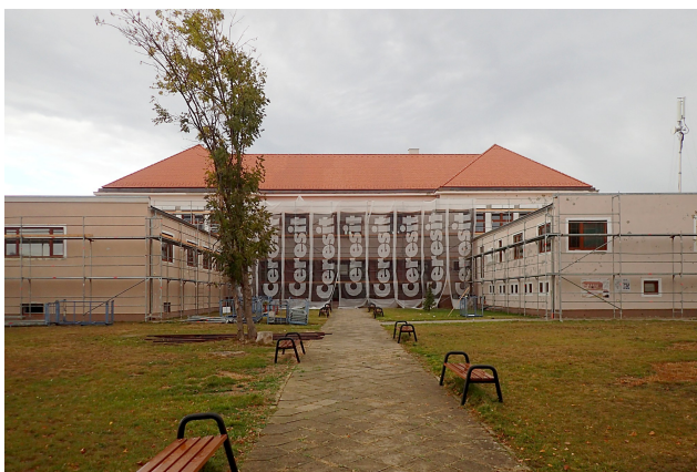
Obr. 2: Čelní pohled – JZ fasáda s navazujícími přízemními křídly.
