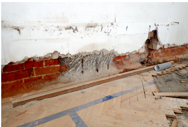
Obr. 8: 1. NP, tělocvična – nová drážka v patě obvodové stěny a železobetonovém pilíři.
