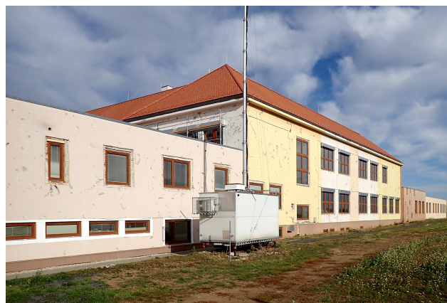
Obr. 3: Pohled na JV fasádu a SV křídlo.
