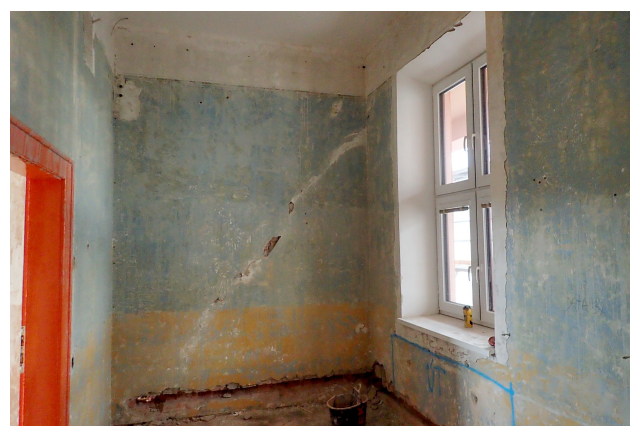
Obr. 5: 1. NP, kabinet (110) – stěna mezi kabinetem a zádveřím hlavního vstupu.
