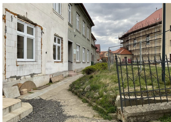
Domy "zapadlé" u kostela - lékárna
