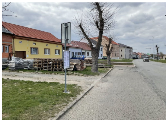
Autobusová zastávka v kolizi s příjezdy k RD
