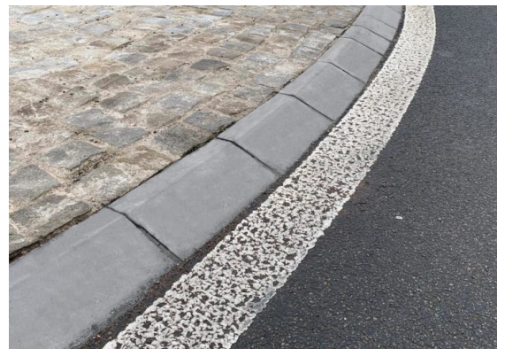
Zkosený obrubník uzpůsobený pro vjezd
