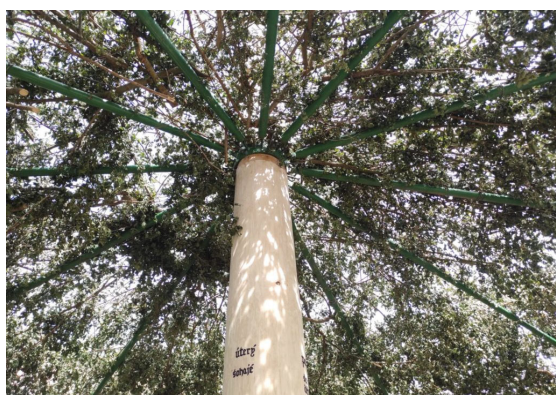
Hody - kotvení konstrukce k májce
