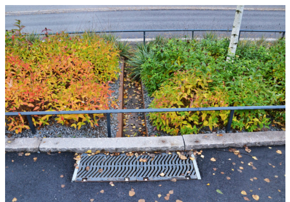
Odvod dešťových vod u dešťového záhonu
